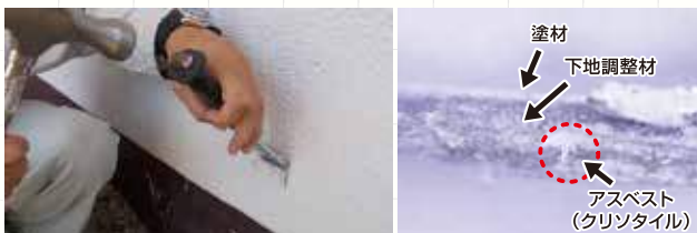
外壁仕上塗材の採取状況
