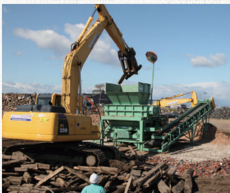
▲災害後は家具や畳など、大量の大型ごみの処理が現場にのしかかります。写真は東日本大震災のときに仙台へ剪断式破碎機のプラントとオペレーターを派遣したときのようす
