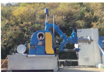
▲黒土川小水力発電で使用される発電機。33.1キロワットの発電を見込む
